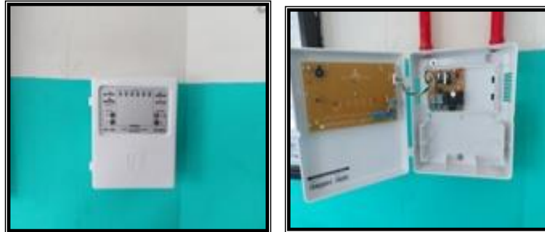
Figuras 32 e 33: Central de alarme convencional sendo montada
