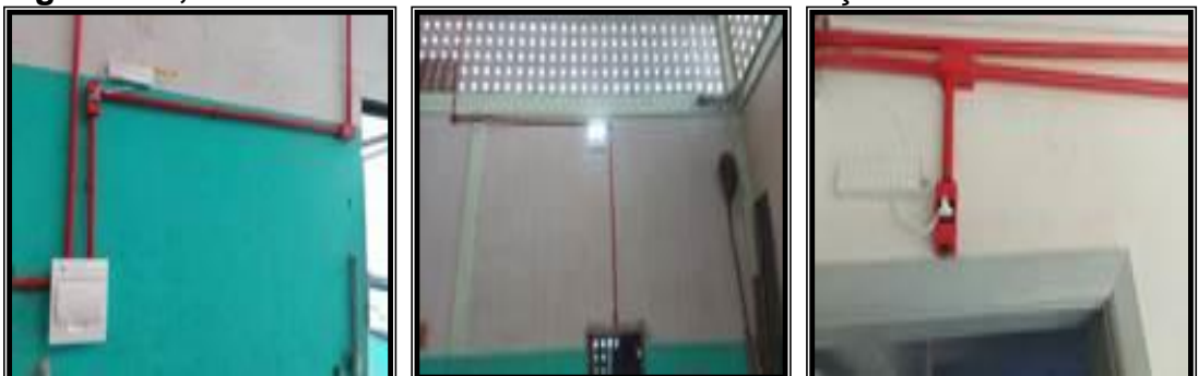
Figuras 39, 40 e 41: Eletrodutos Montados com a fiação elétrica
