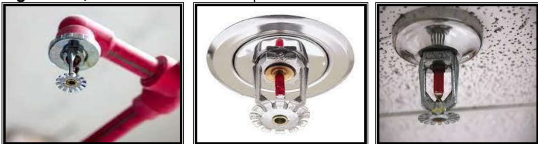
Figuras 25, 26 e 27: Sistema de Sprinklers
