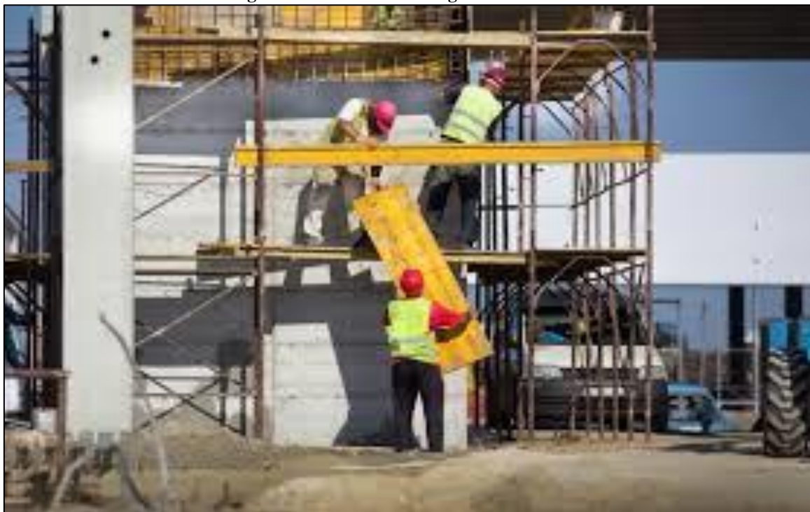
Figura 8: Trabalhadores seguindo a NR – 35.
